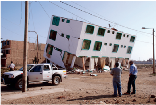
Edificación a punto de desplomarse luego del terremoto de Pisco (2007).
