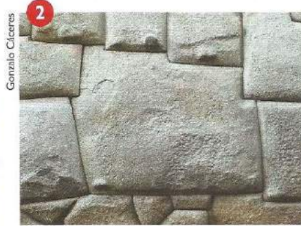
Estilos de acabados del trabajo en piedra: irregular con argamasa (1), tallado poligonal, sin argamasa (2), y piedra de tallado poligonal (3).
