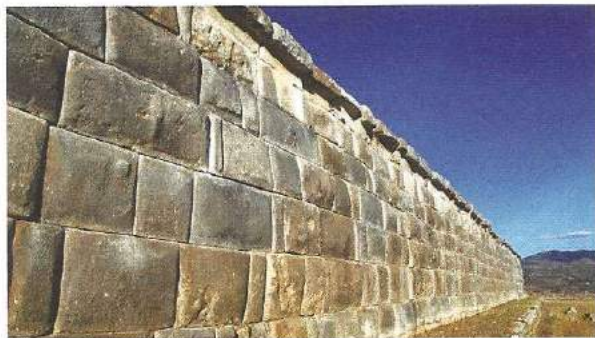
Muros de piedra, Huanucopampa.
