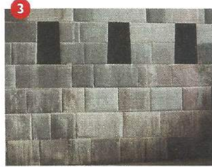
Estilos de acabados del trabajo en piedra: irregular con argamasa (1), tallado poligonal, sin argamasa (2), y piedra de tallado poligonal (3).
