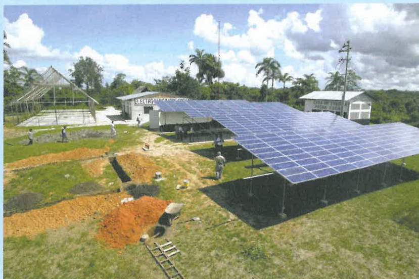
Instalación de paneles solares en Cajamarca
