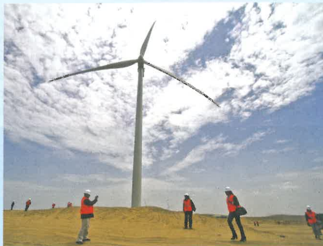
Aerogeneradores instalados en Pacasmayo, en la región de La Libertad
