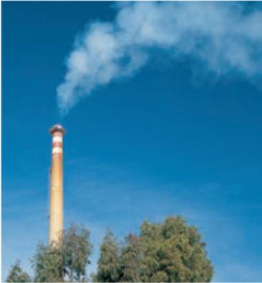
Las chimeneas, al ser tan altas aprovechan la velocidad del viento. Este viento crea una diferencia de presión entre la base y la boca de la chimenea, lo que facilita la eliminación de gases.
